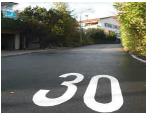
Wiederholt Tempo-30-Signete auf der Fahrbahn
