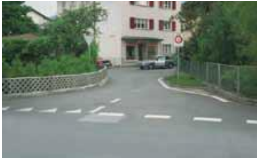
Torelement zu Beginn der Tempo-30-Zone
